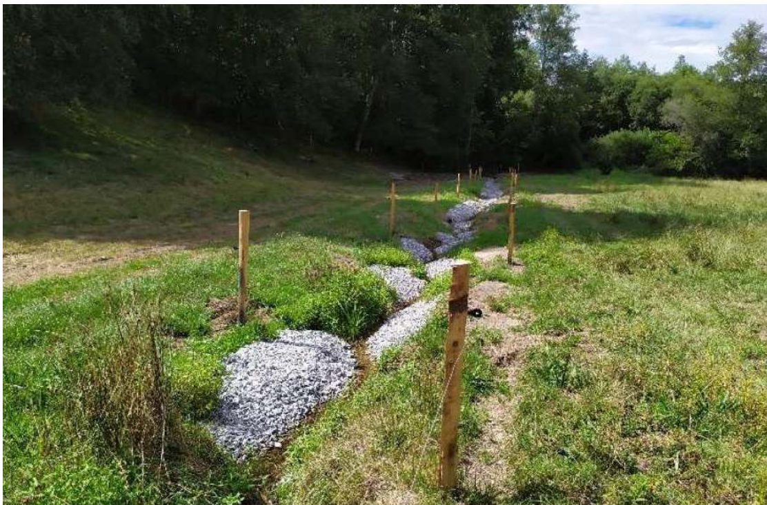
Illustration 27 : Création de banquette sur un affluent de la Leyrenne (Source : CCCSO)
